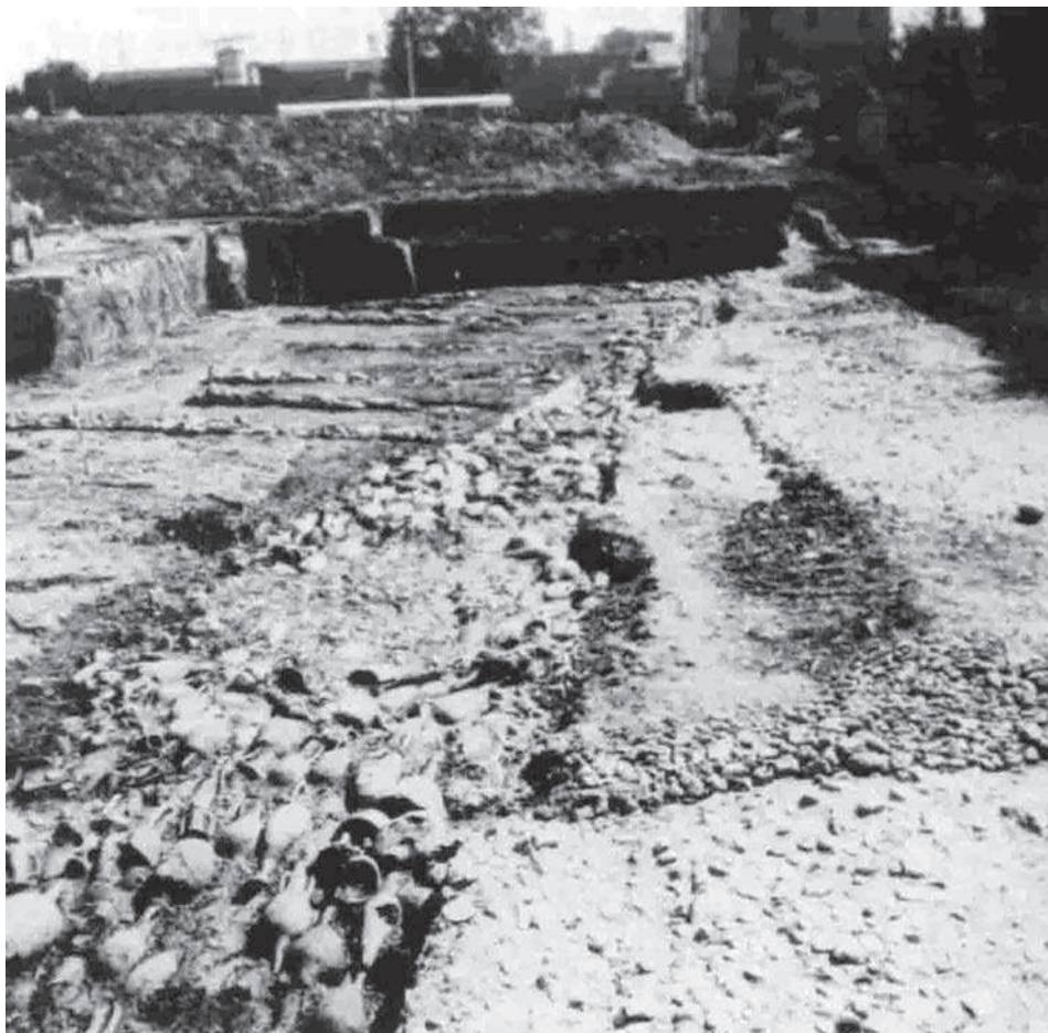
FIG. 2. Bonifica con anfore impiegata per sottofondare la massiciata della via Parma-Brixellum rinvenuta in via Palermo a Parma (da MARINI CALVANI 1992).
