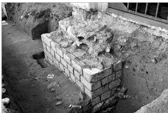
fig. 2 – Vicenza, Corso Fogazzaro: secondo plinto rettangolare, con dettaglio della risega e del paramento in opus vittatum (Archivio SBAV).
