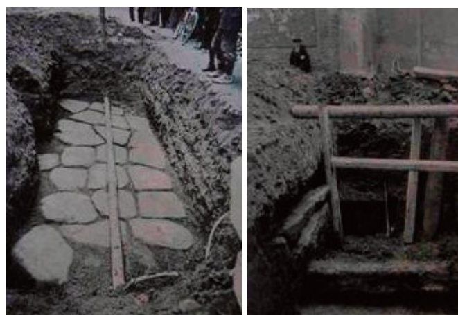
Figuras 25 y 26. Due immagini del tratto stradale (basolato e sottostrutture lignee) messo in luce a in via Garibaldi a Ferrara nel 1911 (da BORGATTI 1912).
