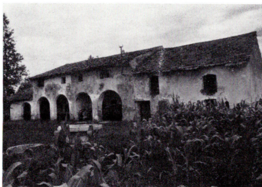
Casa padronale, con annessi rustici, del XVIII sec. a Fossadelle di Ponte di Piave.
