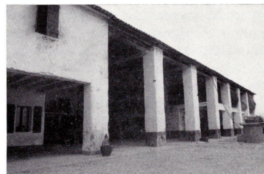
Porticati di una casa colonica tardo-settecentesca, a Negrisia (Ponte di Piave).
